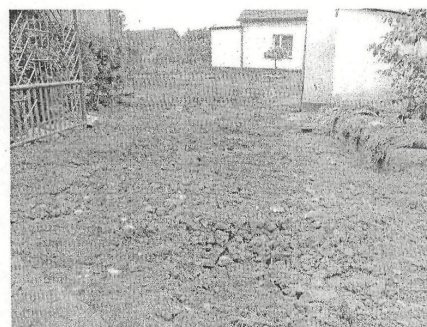
Doszczętnie zniszony wjazd na jedną z posesji
