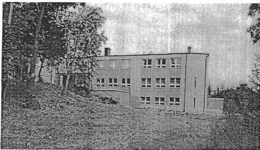
Fot. 9 Budynek Szkoły Podstawowej
