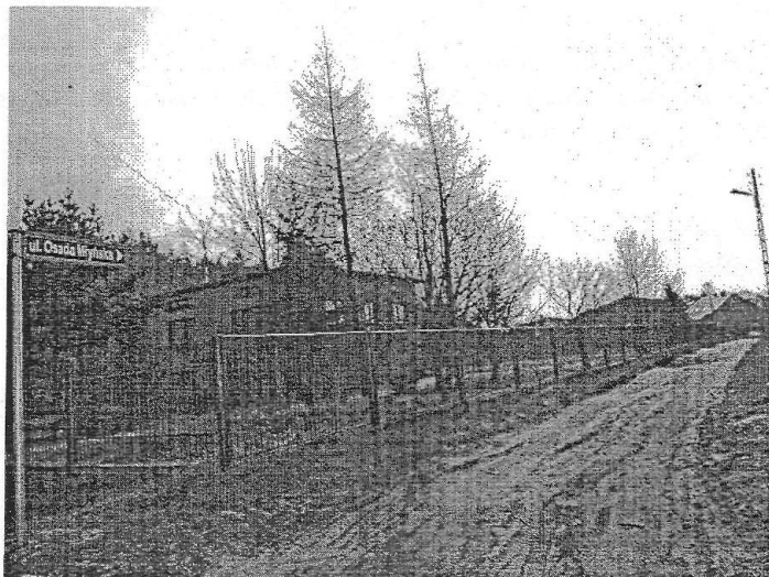
Fot. 11 Droga gminna przy ul. Osada Młyńska
