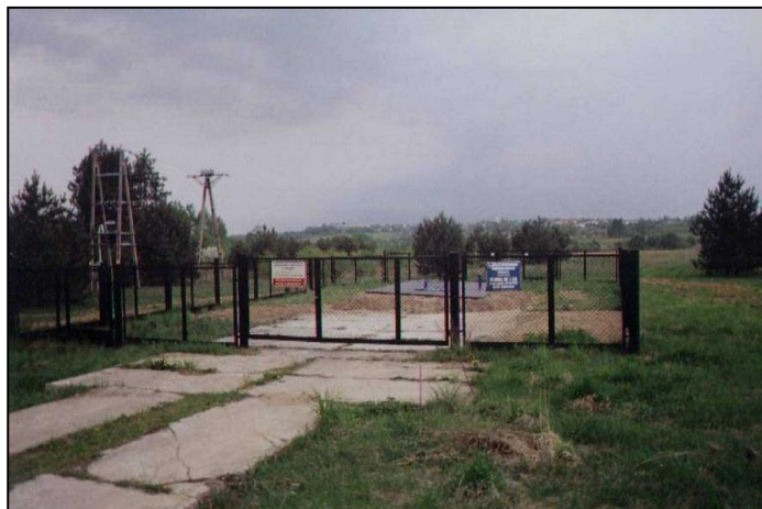
Ujęcie wody w Parkoszowicach w gminie Włodowice
