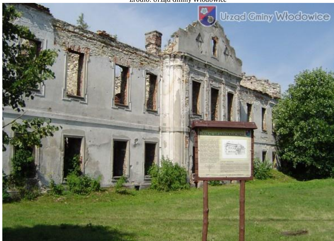
Ruiny pałacu we Włodowicach .Informacja o obiekcie
